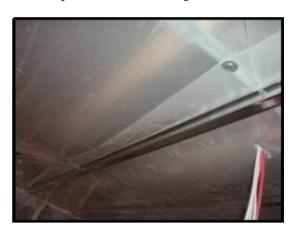
7. Installer le carton fibre de 7/16" X 6" de large à 2" sous les solives aux murs porteurs et murs extérieurs qui tiendra le polyéthylène du plafond lors du soufflement des plafonds, pose de fourrures 1 x 3 aux pourtours des fenêtres et portes, installer le matelas sur les murs en partant sur le carton fibre en haut et brocher sur les colombages murals et faire l'installation des barres résilientes pro à 2" sous le carton fibre et le reste à 24" c/c 4 barres sur 8'.
