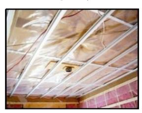
5. Les sorties d'air devront être ancrées à la suspension du plafond et les placer le plus bas possible vers le plafond, souffler un peu plus d'isolant sur ces tuyaux de ventilation pour les planchers sans béton, visser un gypse 5/8" au-dessus de chaque sortie d'air (la largeur entre les solives x 48" de long), visser au plancher de base pour diminuer les sons traversant par le plancher.
