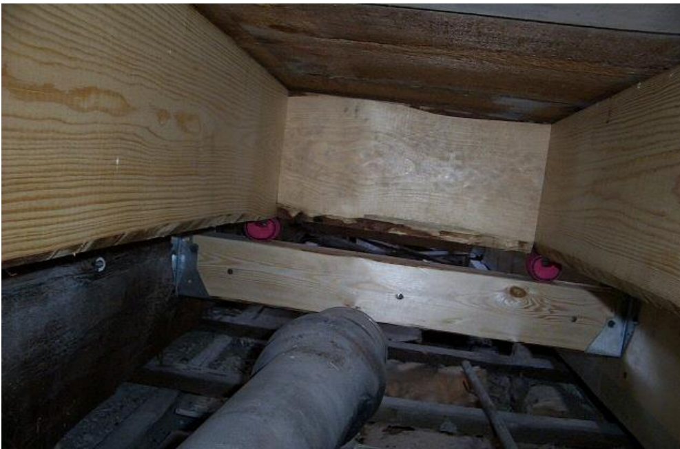
Suspension de structure de plancher en compression
