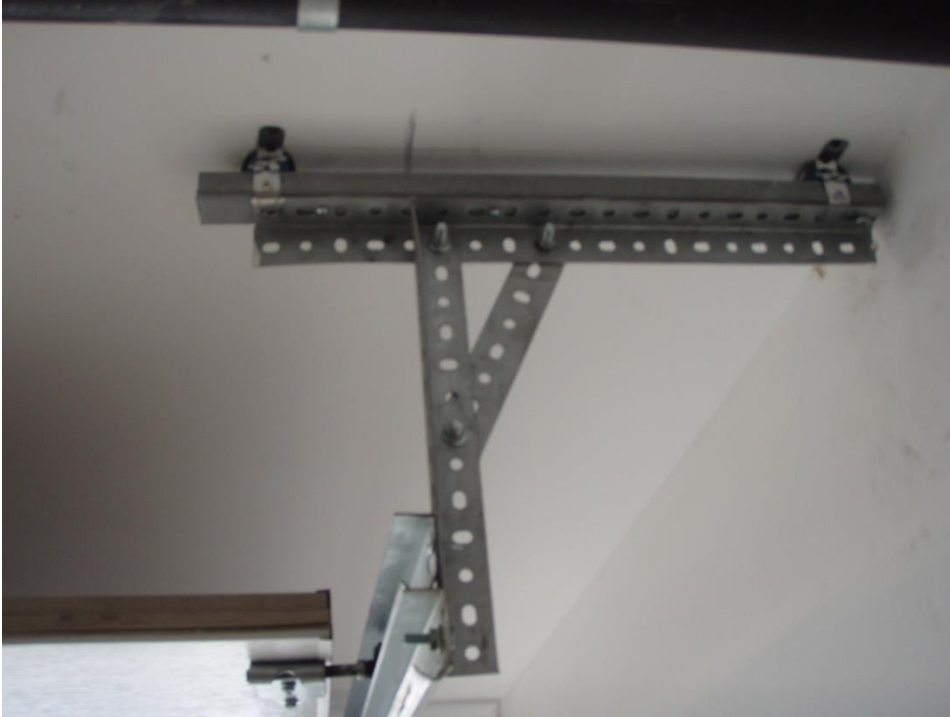
Rails de porte de garage sur suspension Cali
