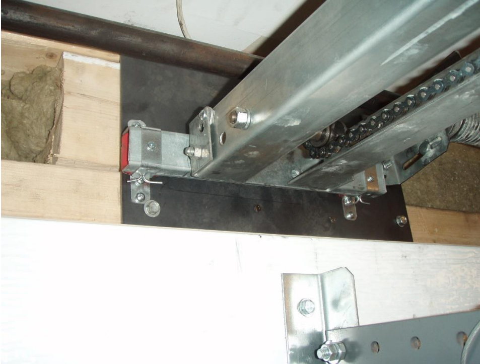
Rail centrale désolidarisé avec système Cali
