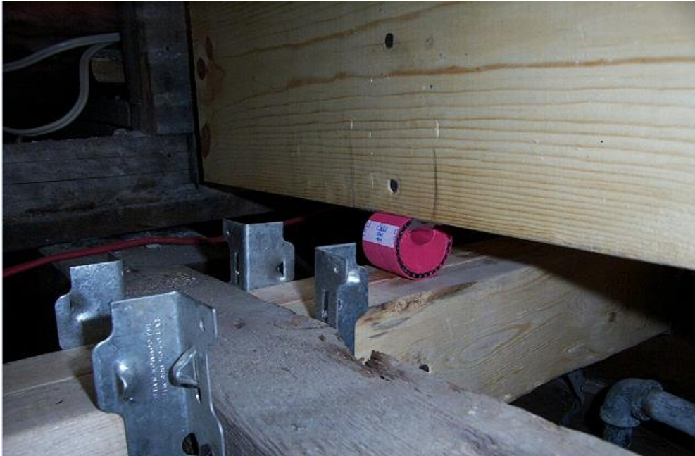
Suspension de structure de plancher
