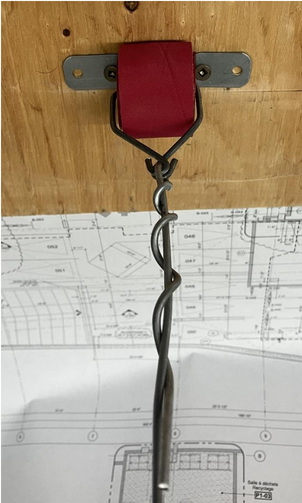
Suspension Cali au béton avec broches de suspension
